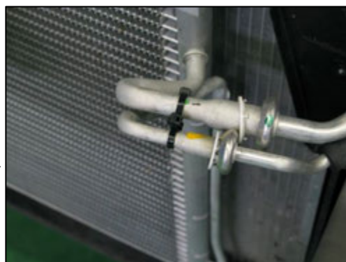
細い方のパイプを上側に近づけ、タイラップで固定
