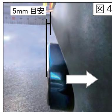
テールを矢印の方向に押し込みながら、フランジ部のボルトとナットの締め付けを行ってください
